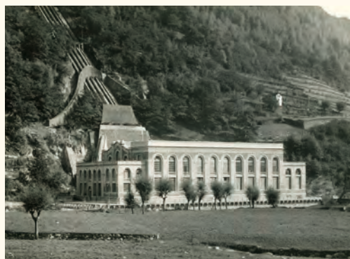
Impianto di Grosotto
