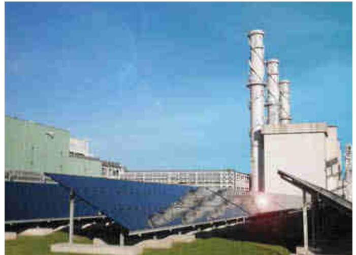
Sopra: la centrale fotovoltaica di Chivasso.
