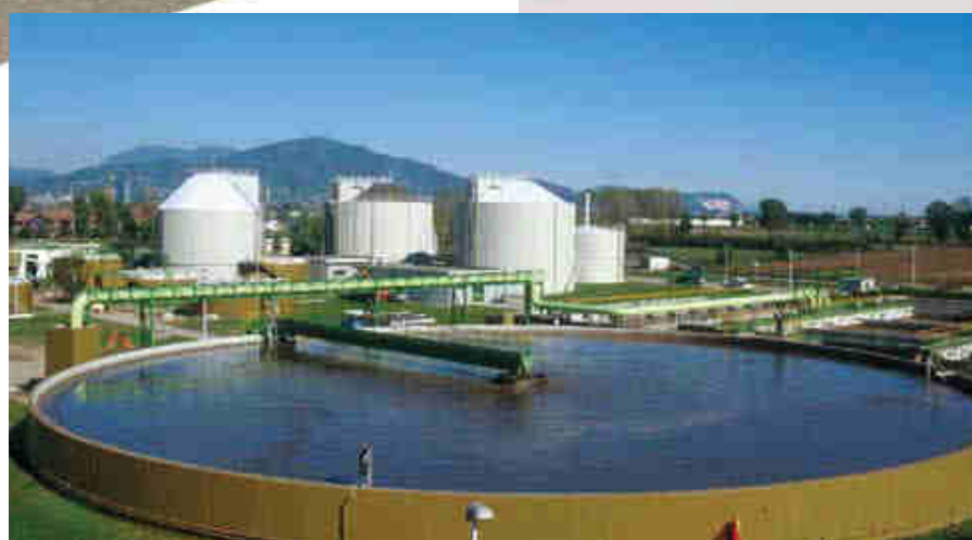
A destra: il depuratore di Verziano. Sotto: una vasca di trattamento.
