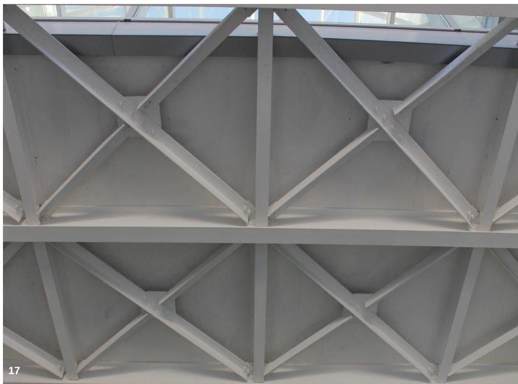
Esempio di profili a L per controventatura
