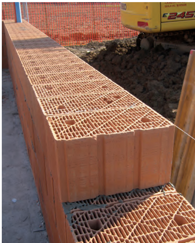
Sottosistema ET con POROTON® PLAN
