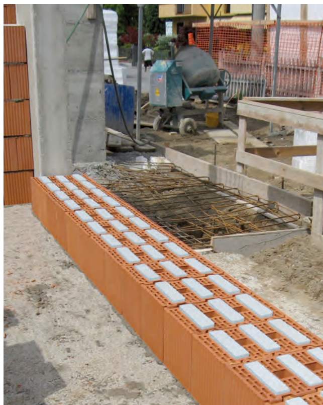
Sottosistema ET con blocchi con Isolante Integrato
