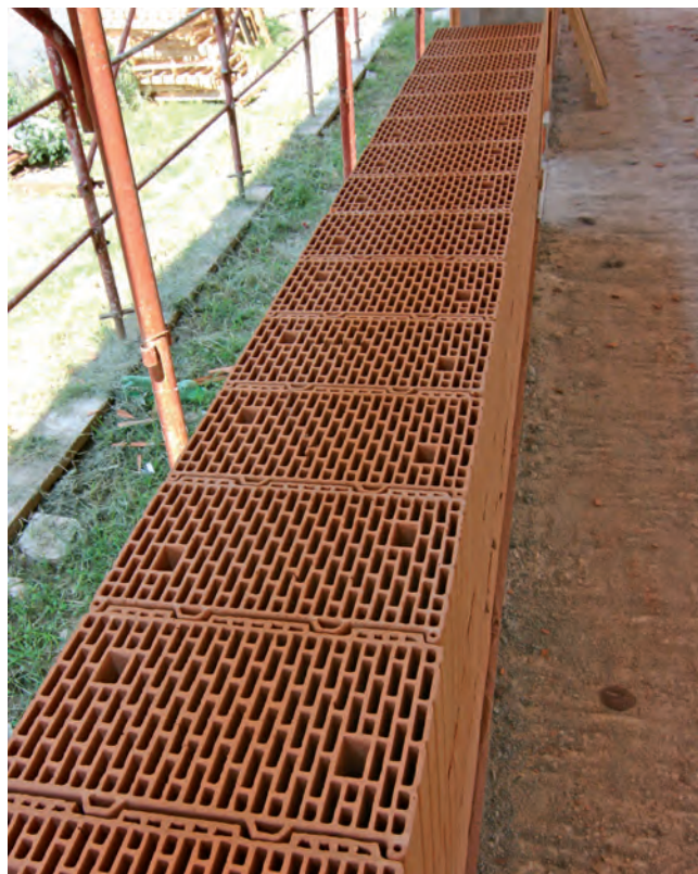
Sottosistema ET con POROTON® Setti Sottili
