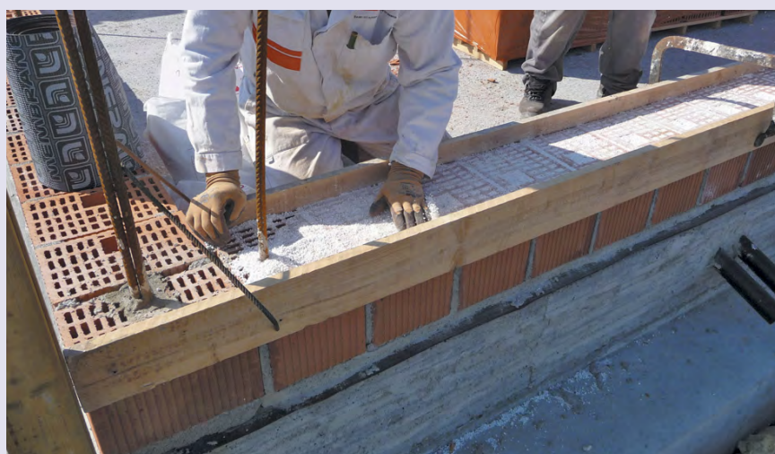
Fig. 2 - Taglio termico alla base mediante riempimento con perlite dei fori del primo corso di blocchi in laterizio.
