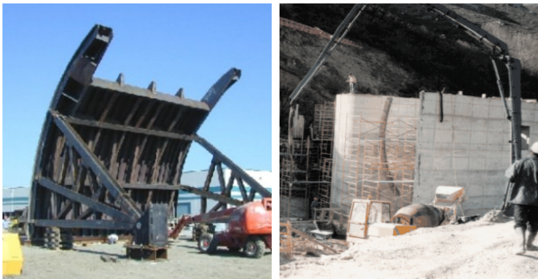
Foto 5.15: paratoia radiale (sinistra) e alloggiamento di una paratoia a settore su una pila di calcestruzzo (destra)
