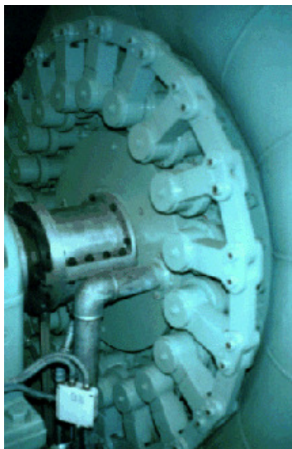
Foto 6.4: anello di azionamento delle pale del distributore di una turbina Francis ad asse orizzontale
