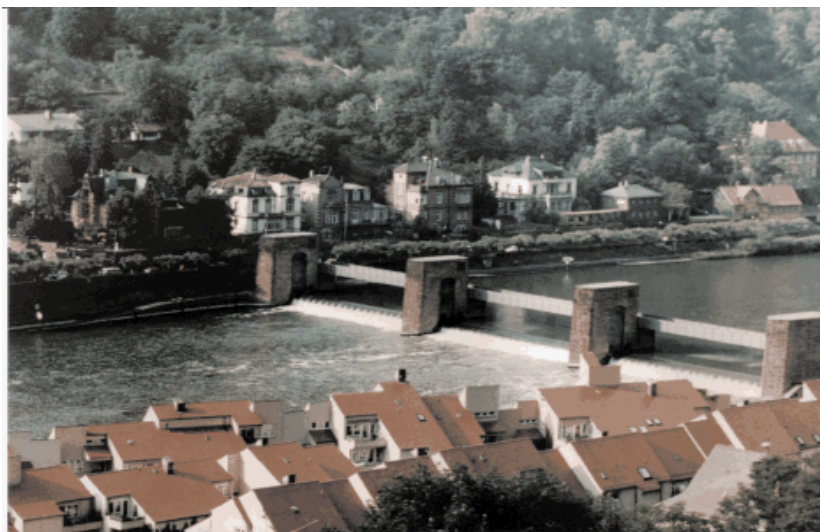
Foto 7. 12: Impianto di Neckar
