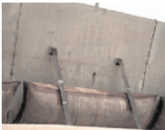
Foto 5.6: Panconi manovrati da camere ad aria gonfiabili
