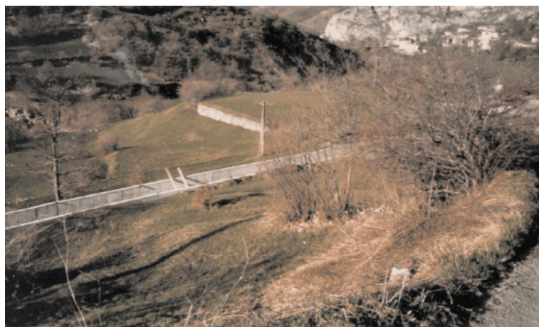
Foto 7.6: Fase di costruzione – getto del calcestruzzo
