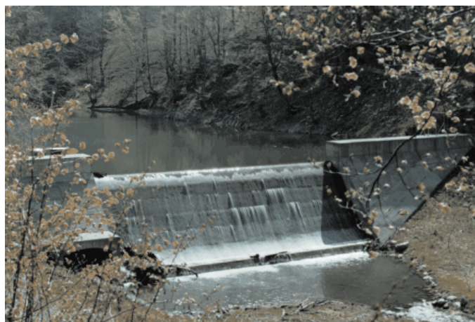
Foto 5.4 Traversa con profilo di Creager
