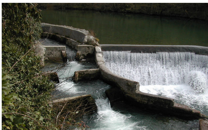
Foto 7.13: Passaggio per pesci di costruzione rustica
