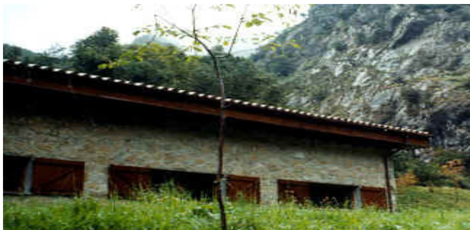
Foto 7.10: l'edificio di centrale
