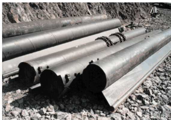
Foto 5.9: Paragalleggianti prefabbricati
