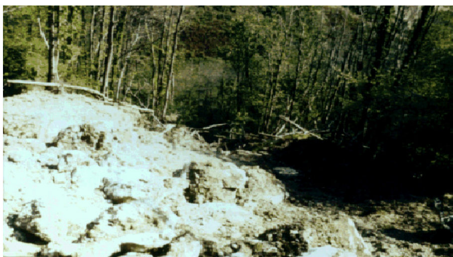
Foto 4.10: la traversa compromessa dalle infiltrazioni
