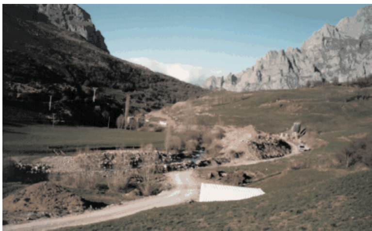
Foto 7.5: Fase di costruzione – scavo
